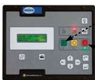
Figura 01 - painel do gerador
